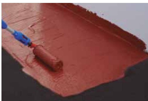
Impermeabilizzazione di carta catramata
