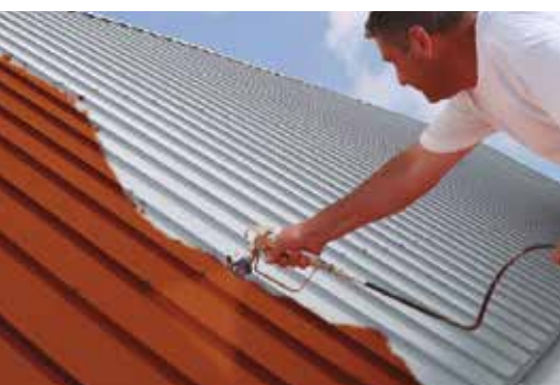
Impermeabilizzazione di un supporto metallico
