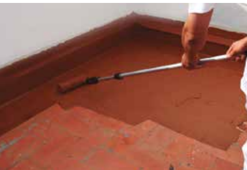
Impermeabilizzazione di terrazze
