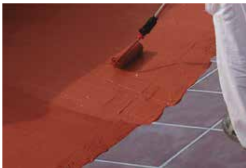
Impermeabilizzazione di piastrelle
